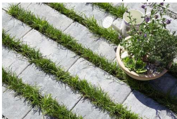
Řešení odstavných ploch - betonová dlažba zasakovací Aqualines Best, barevné provedení colormix Brilliant nebo Arabica - parkovací část zasypaná kamínkem, pojezdná část spáry zatravněné
